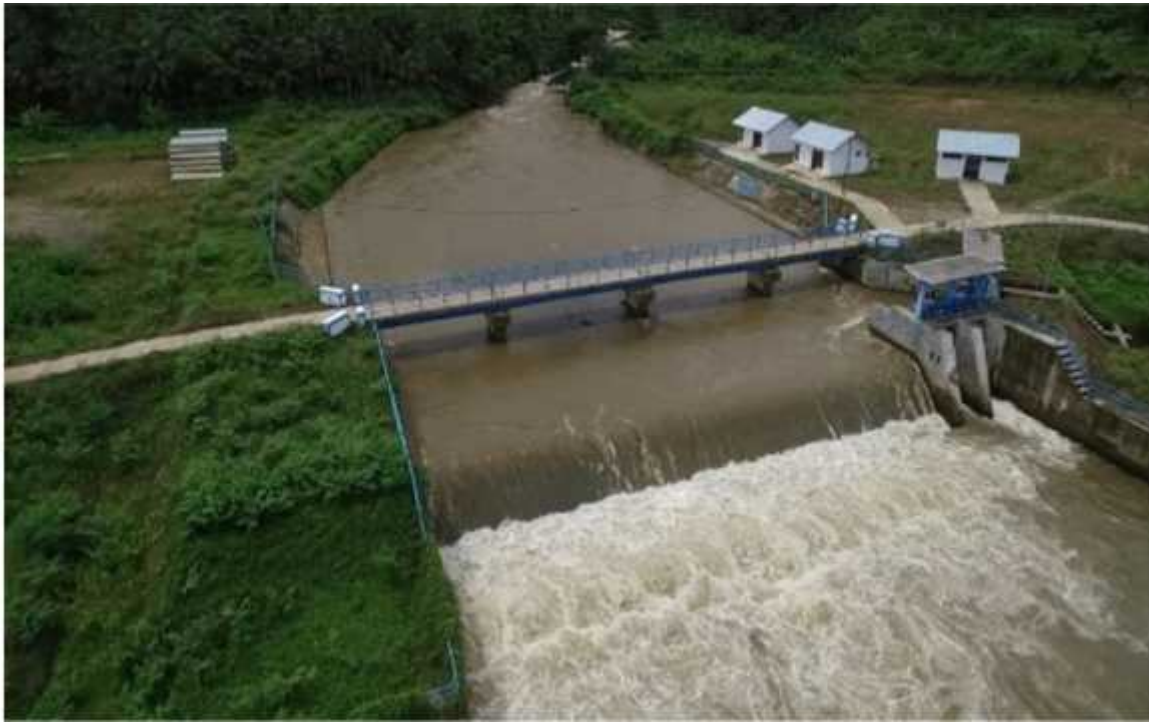
Gambar 5. 8 Kondisi Bendungan Pembangunan Jaringan Distribusi Sekunder SPAM Regional Bentengkobema
